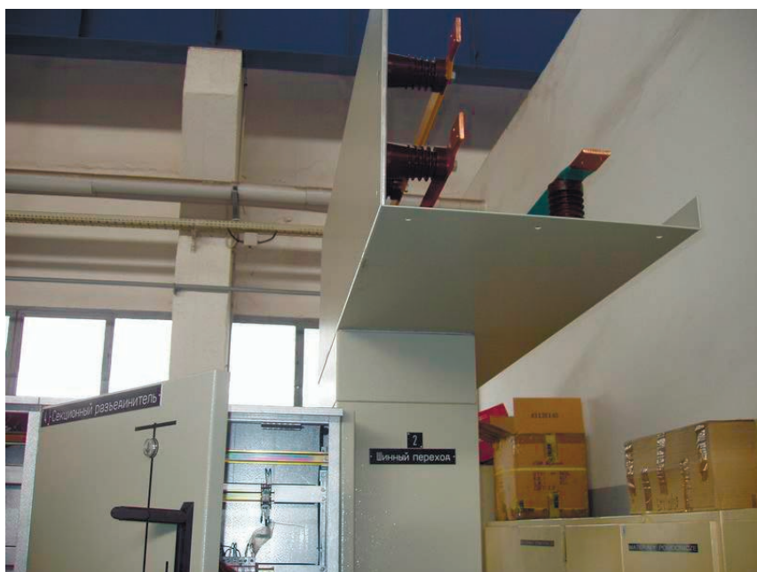
Рис. 20 Шинный мост
